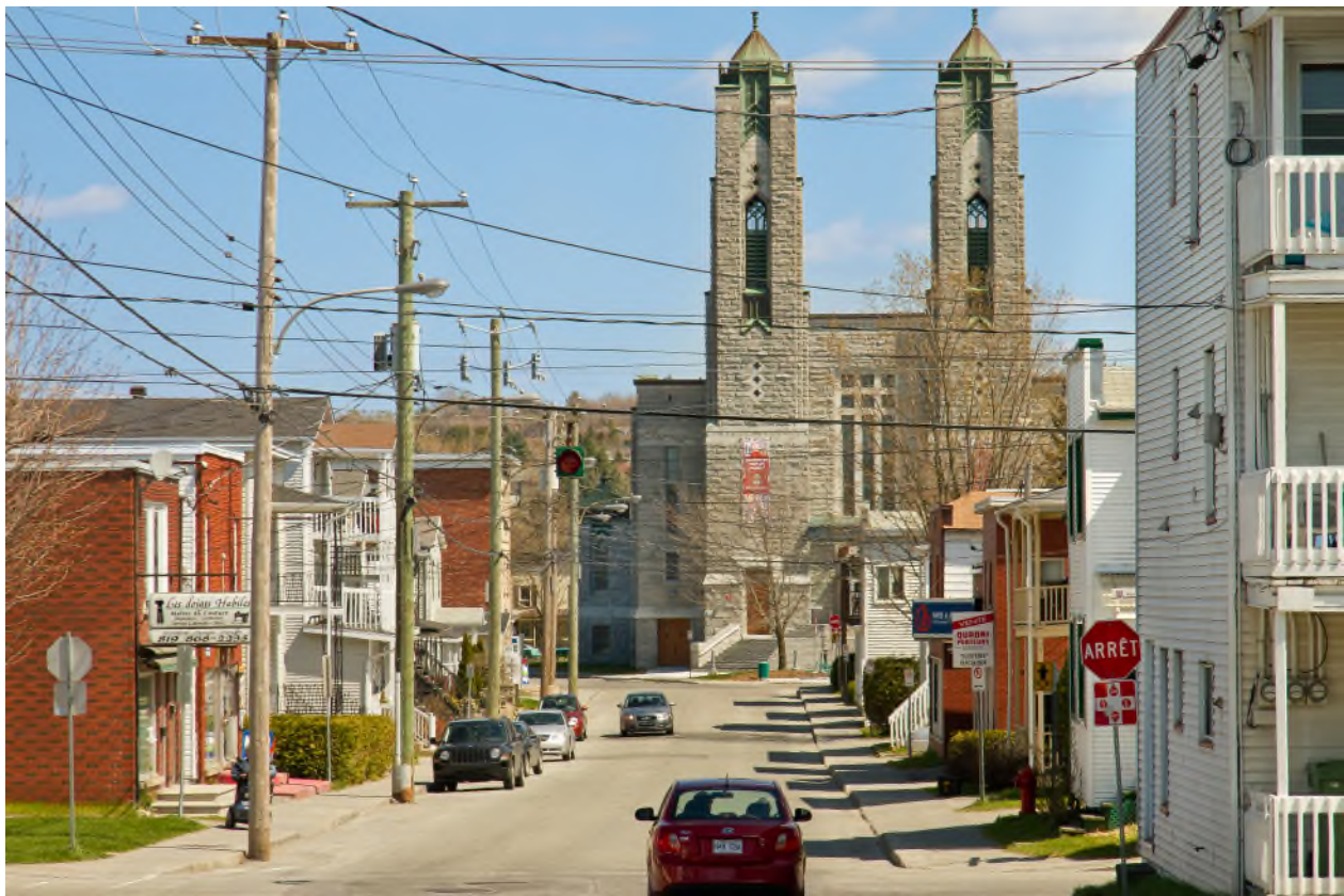
IMAGE 34. VUE SUR LA BIBLIOTHÈQUE MEMPHRÉMAGOG DANS LE QUARTIER DES TISSERANDS.
